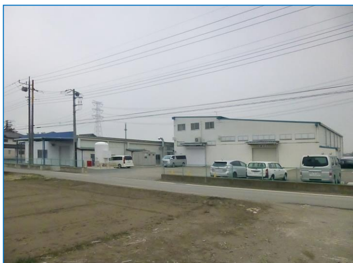
太田工場全景（清潔庫・不潔庫を建物から区分け）
